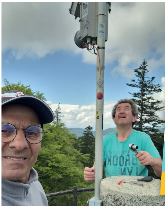
Gürkan et Pierre à l'ouvrage.
