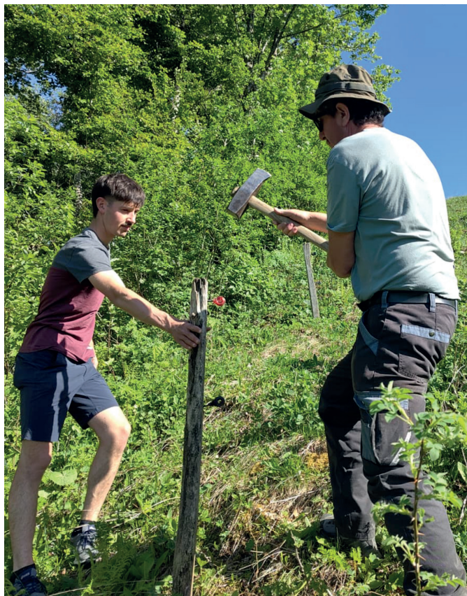
Pose de la barrière à Raimeux Nord. C'est Diego Menozzi qui est désormais responsable du site. Pierre était de la partie ce printemps pour l'épauler. (dm)
